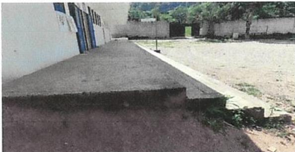
Foto1: Se sustituirá la torta de cemento por piso de granito en el corredor donde se encuentran las aulas por motivo de deterioro.
